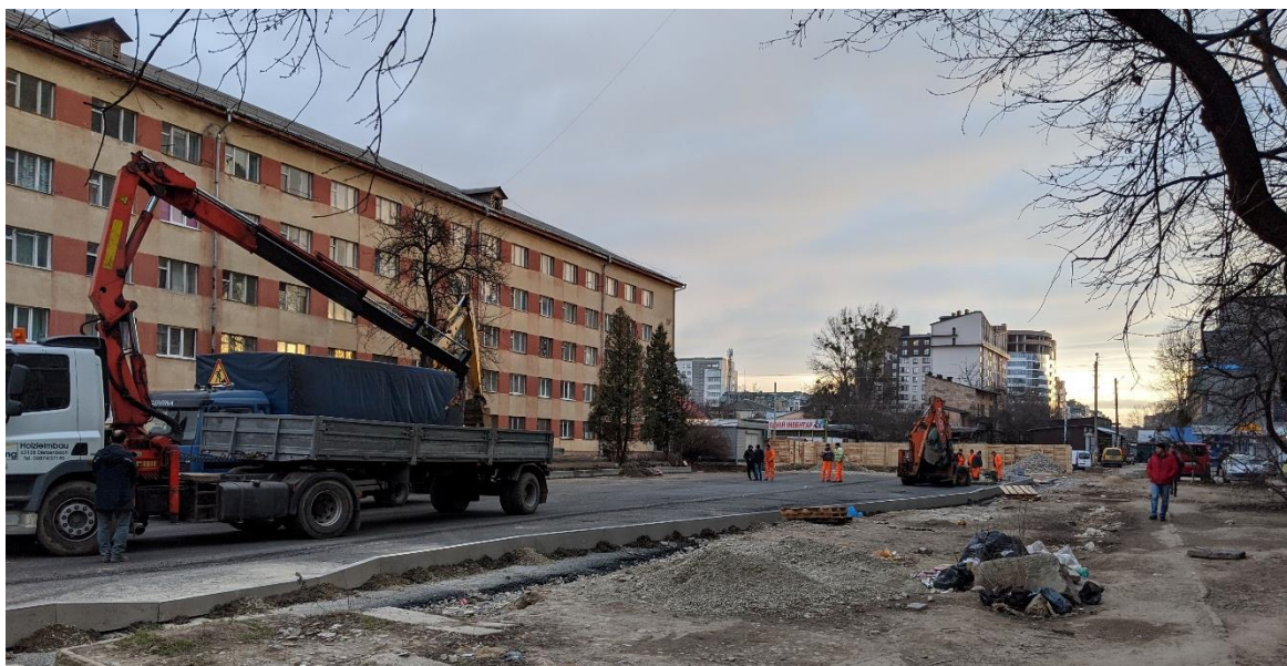
Будівництво Північного бульвару на ділянці від вул. Бельведерської до вул. Панаса Мирного
