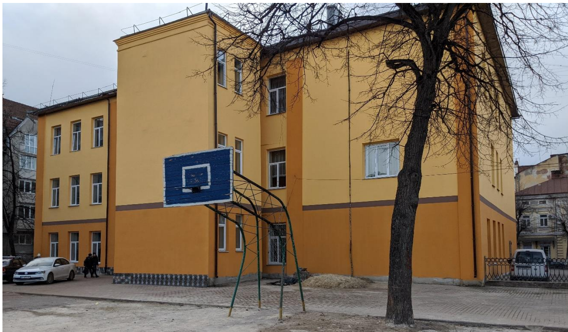
Ремонтно-реставраційні роботи корпусу №1 ЗОШ №7
