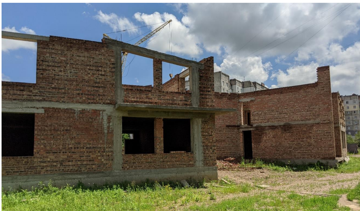
Будівництво дитячого садка в м-ні "Каскад"
