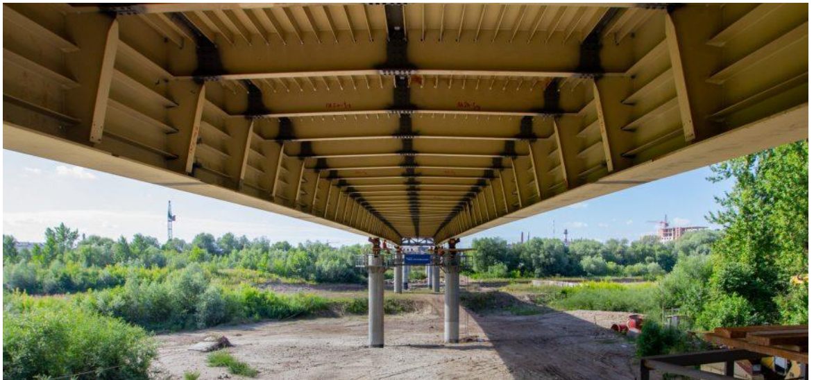
Будівництво моста через річку Бистриця Солотвинська та транспортної розв'язки в районі вул. Хіміків-Надрічна (III-черга – «Будівництво моста через річку Бистриця Солотвинська в районі вул. Хіміків-Надрічна в м. Івано-Франківську»)
