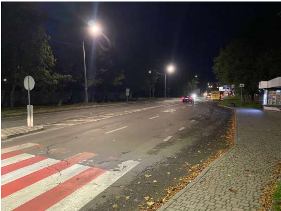
Освітлення вул. Довженка (від вул. Чорновола до вул. Сухомлинського)
