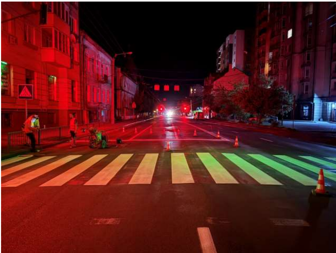
Нанесення дорожньої розмітки на вул. Незалежності
