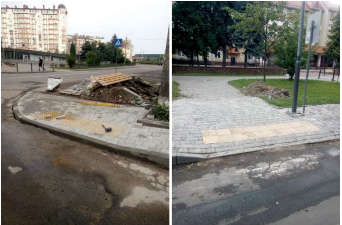
Пониження з елементами доступності на тротуарі поруч Івано-Франківської обласної дитячої клінічної лікарні на вул. Є. Коновальця
