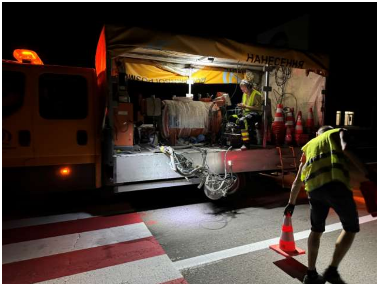
Процес нанесення дорожньої розмітки на вул. Івасюка
