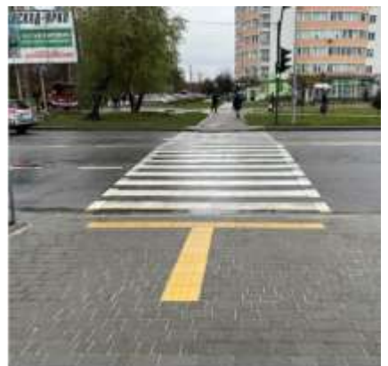
Пониження з елементами доступності на пішохідних переходах на вул. Миколайчука
