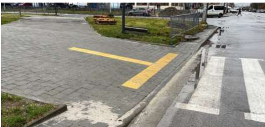
Пониження з елементами доступності на пішохідних переходах на вул. Стуса
