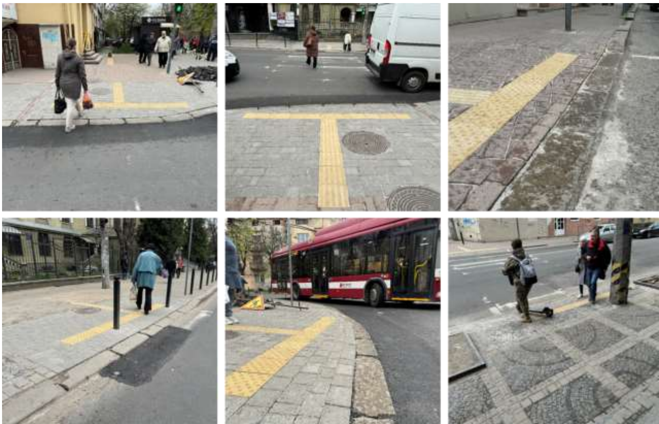
Пониження з елементами доступності на пішохідних переходах на вул. Васи́ліянок (перехрестя з вул. Вовчи́нецькою)
