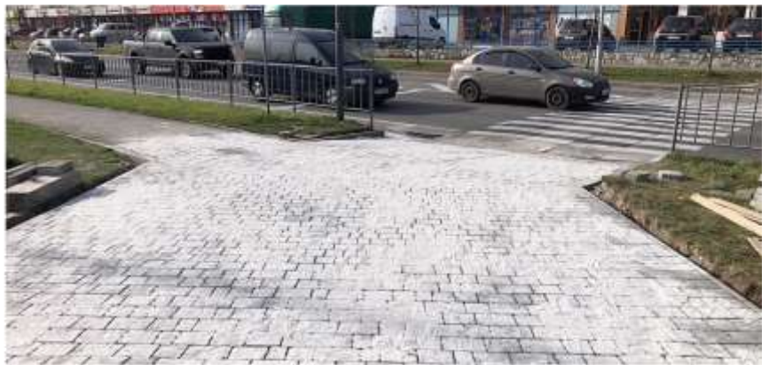
Пониження з елементами доступності на пішохідних переходах на вул. Миколайчука
