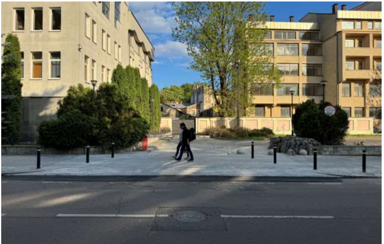
Поточний ремонт тротуару з улаштуванням підвищеного пішохідного переходу на заїзді/виїзді з майданчика для тимчасового зберігання транспортних засобів на вул. Грушевського, 32
