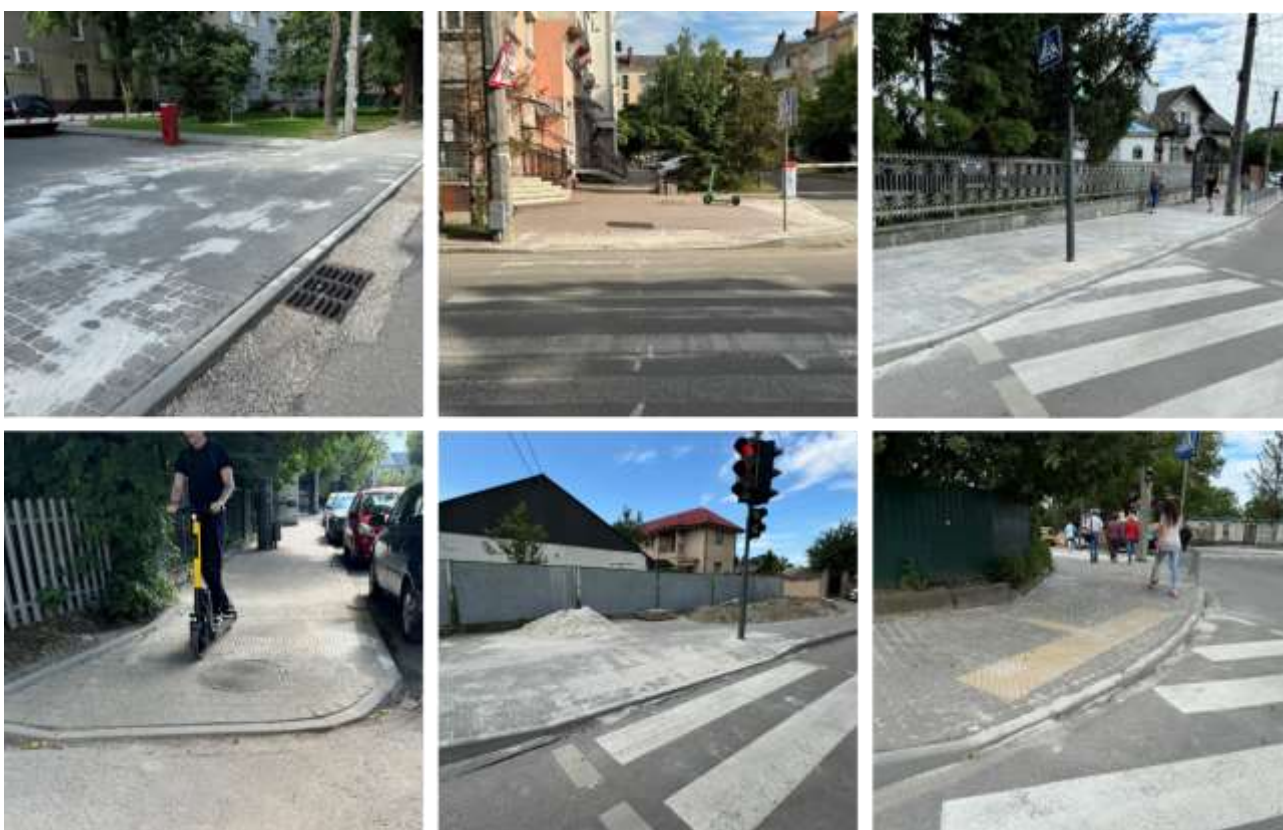
Пониження з елементами доступності на пішохідних переходах на вул. Вовчи́нецькій (від вул. Васи́ліянок до перехрестя з вул. Депо́вською та Сагайда́чного)
