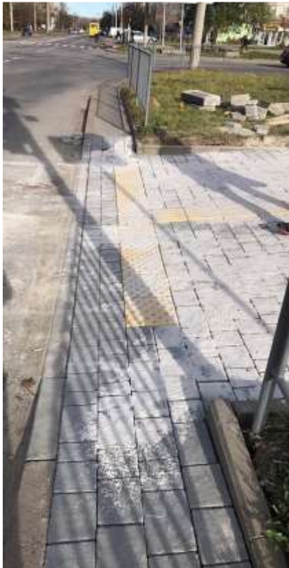
Пониження з елементами доступності на пішохідних переходах на вул. Миколайчука
