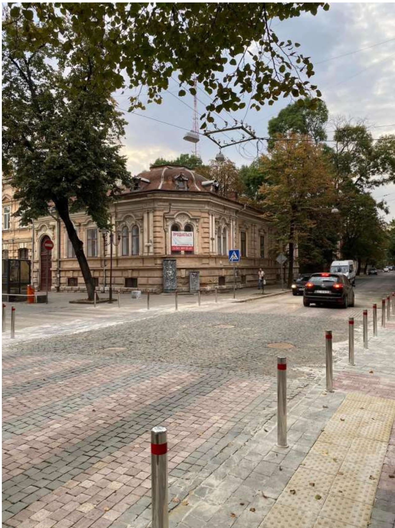
Улаштування засобу заспокоєння дорожнього руху (підвищеного перехрестя) на перехресті вул. Шевченка – Гординського
