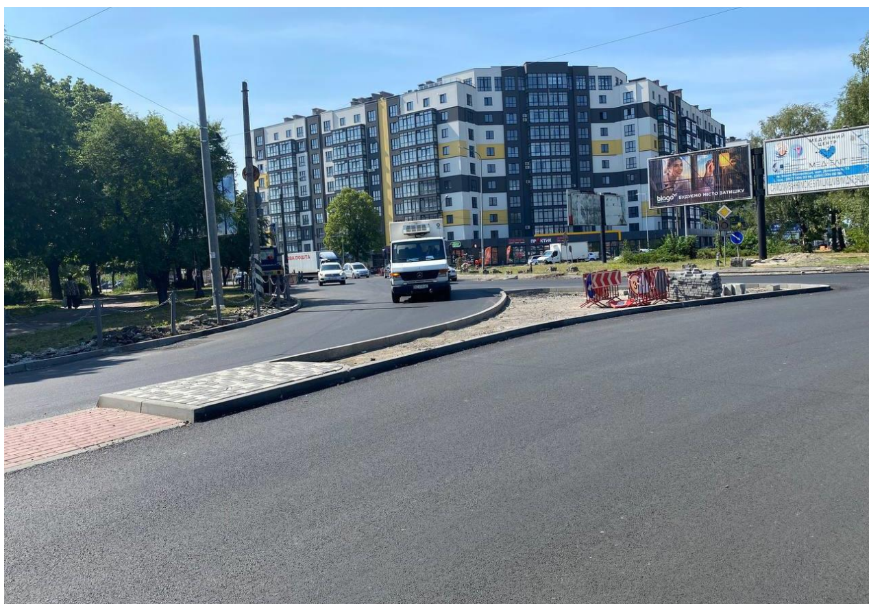
Поточний ремонт дорожнього покриття на кільцевій розв'язці вулиць Г. Мазепи – Довженка – Крихівецька – набережна ім. В. Стефаника
